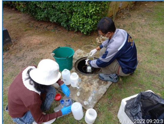
รูปที่ 3.2 แสดงการเก็บตัวอย่างน้ำเข้าระบบบำบัด และน้ำผ่านระบบบำบัด “อาคารส่วนกลาง” (ต่อ)
